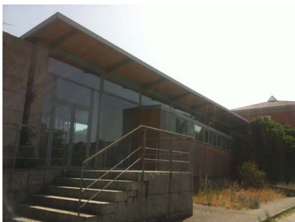
Vista del edificio del antiguo centro médico
