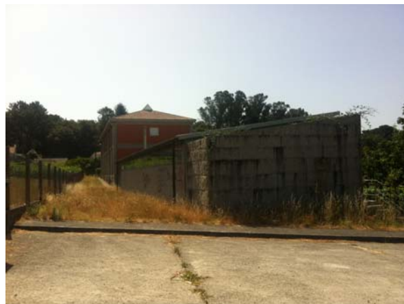
Parte trasera de los edificios
